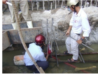
Cấy thép vào lỗ sau khi bơm keo
