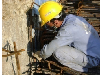
Vệ sinh lỗ khoan trước khi bơm keo
