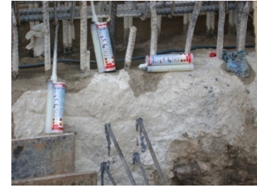
Cấy thép vào lỗ sau khi bơm keo
