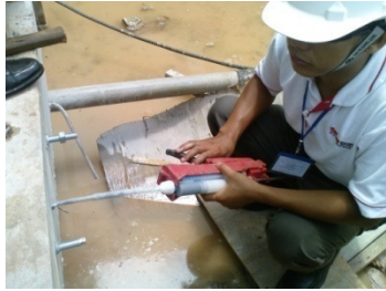
Bơm keo vào lỗ khoan vừa vệ sinh
