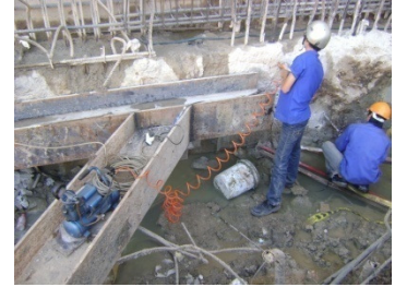
Vệ sinh lỗ khoan trước khi bơm keo
